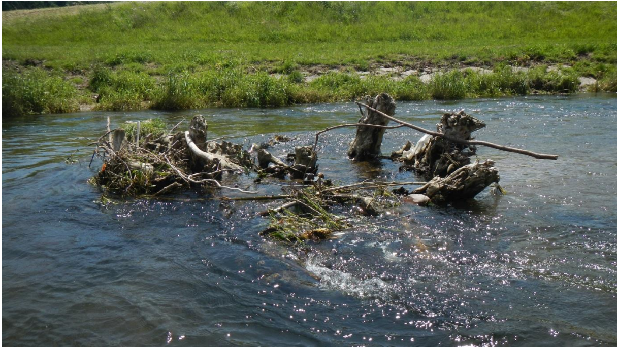
Wurzelnest: Verzahnung dreier Wurzeln mit Hohlräumen bei höherem Abfluss.
